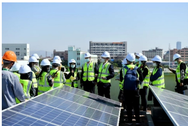
图注：兴业银行支持建设厦门绿泉实业屋顶分布式光伏项目
